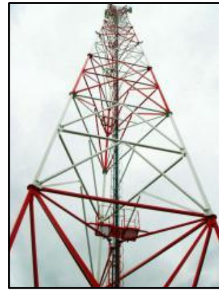
Torre de comunicaciones
